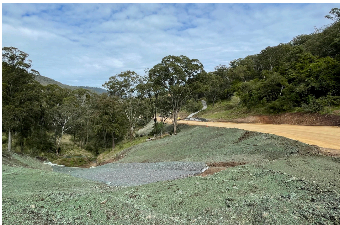
Earth Fill Rehab
